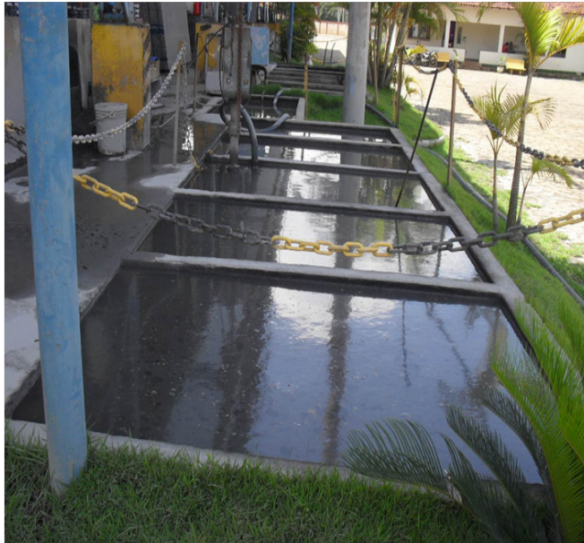
FOTO 6. SISTEMA DE DECANTAÇÃO DO EFLUENTE – DISPOSITIVO DE REAPROVEITAMENTO DA ÁGUA
