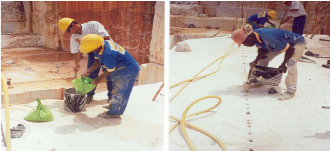
Detalhe da utilização de massa expansiva em maciço rochoso.
