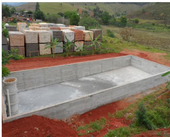
FOTO 9. LEITO DE SECAGEM DE LBRO
