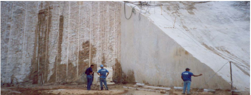
Detalhe de corte em maciço rochoso com utilização da fio diamantado e argamassa expansiva.
