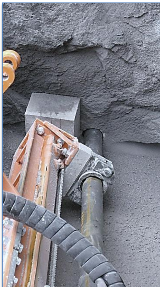
Figura 28 - Foto de perfuratriz realizando furo horizontal na rocha.
